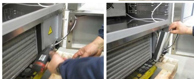
Удалить фиксирующие винты электрического щита.
